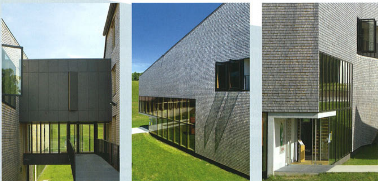
Par opposition à l'aspect massif de l'ancienne maison et de son extension, l'espace de liaison affiche un mode constructif plus léger. / In contrast to the solid appearance of the former House and its extension, the transition space demonstrates a more lightweight method of construction.
