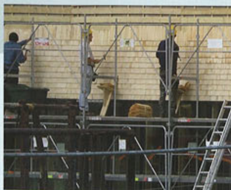
Conditionnement et mise en œuvre des tavaillons, des planchettes d'épicéa de 14 x 33 cm. / Packaging and laying out of shingles, made from 14 x 33 cm spruce boards.
